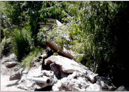
SEBRANGO. El deslizamiento de la ladera ha destruido infraestructuras y tuberías de Sebrango. / REDONDO
