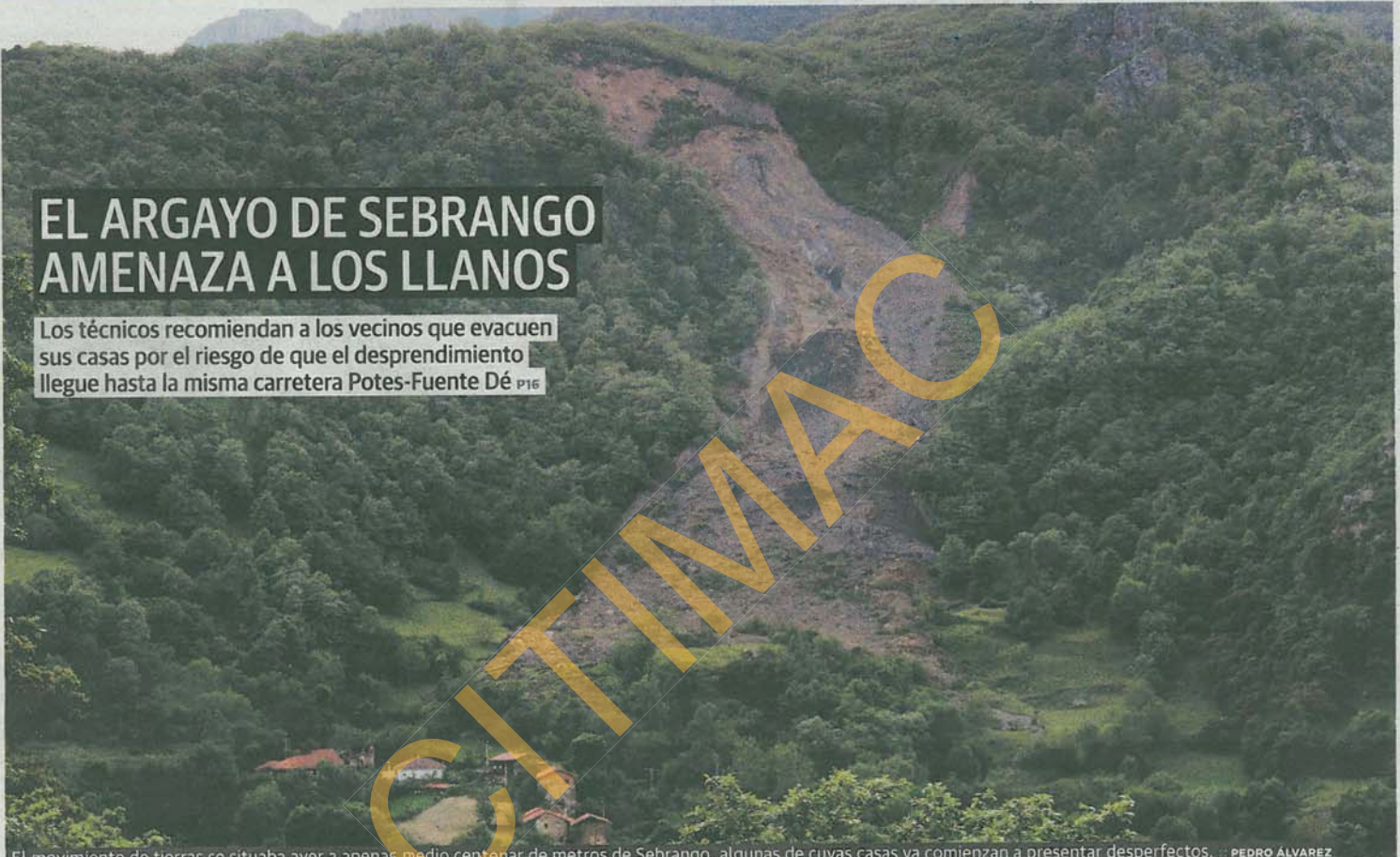
El movimiento de tierras se situaba ayer a apenas medio centenar de metros de Sebrango, algunas de cuyas casas ya comienzan a presentar desperfectos. ... PEDRO ALVAREZ
