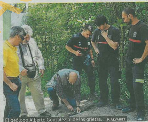
El geólogo Alberto González mide las grietas. P. ÁLVAREZ
